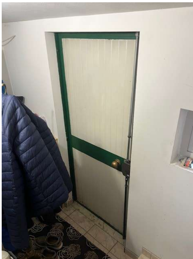
Fotografia 16 – Vista della porta del disimpegno
