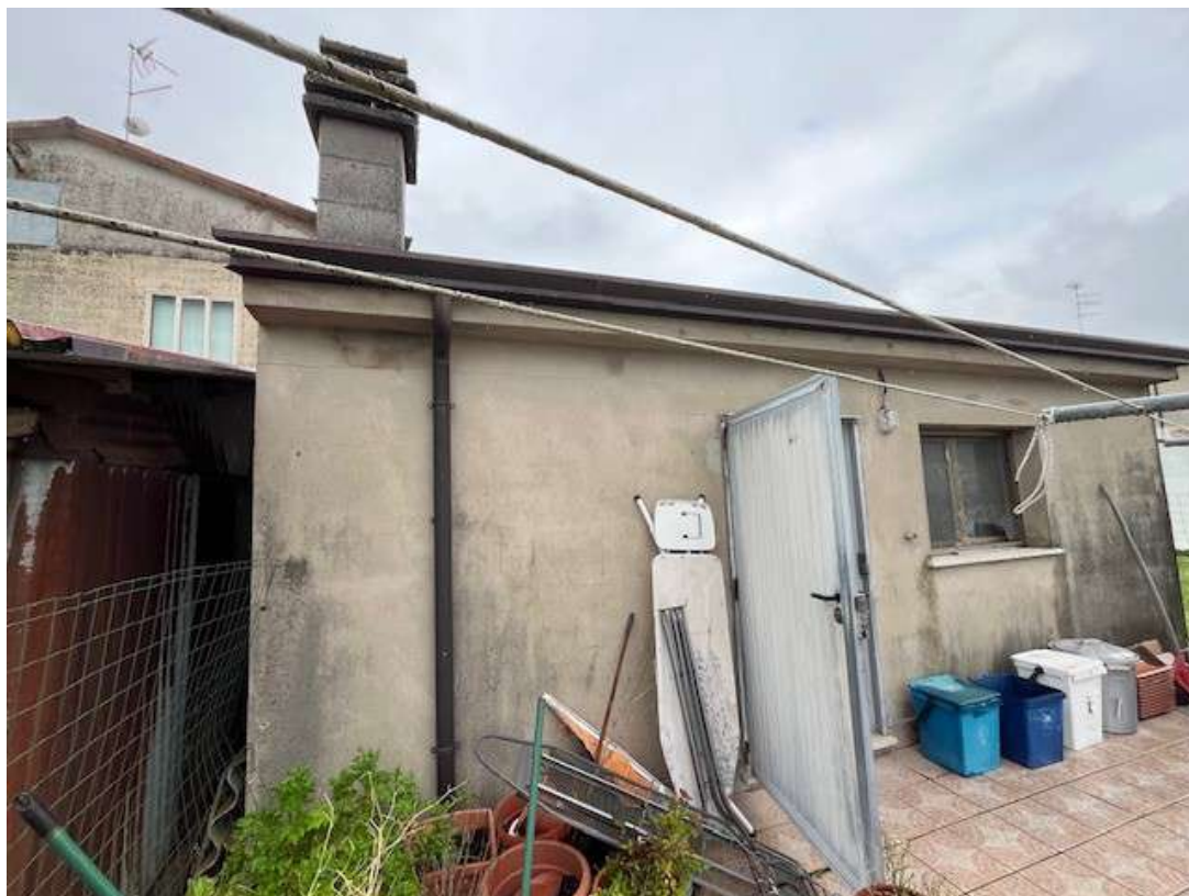
Fotografia 7 – Vista dei locali annessi dal cortile sul retro
