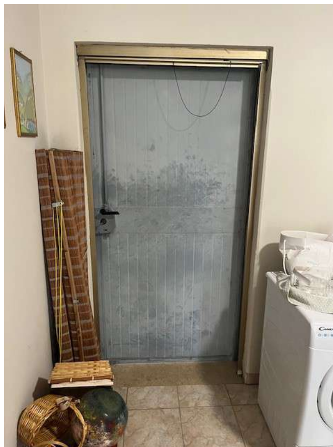
Fotografia 36 – Porta con accesso al cortile retrostante
