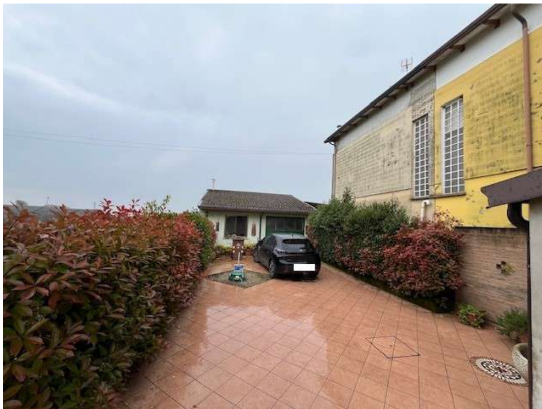
Fotografia 5 – Vista del cortile sul retro con edificio annesso
